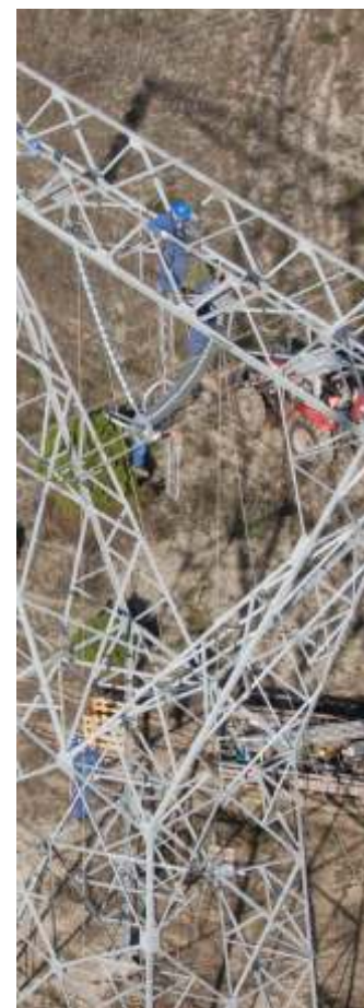
Figura 1 - substituição de cadeias de isoladores em linha de 400kV.
